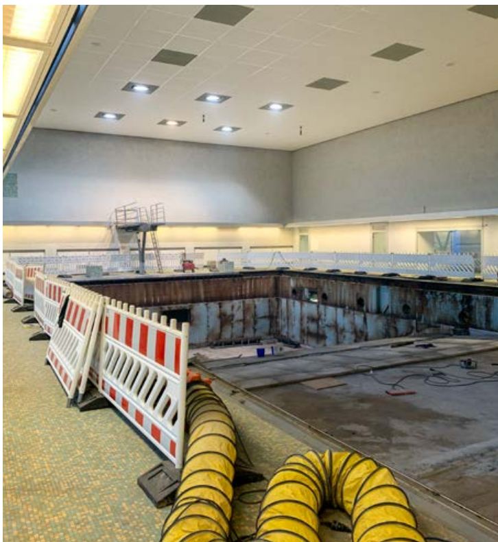
Sanierung des Schwimmbads der Universität Mainz
